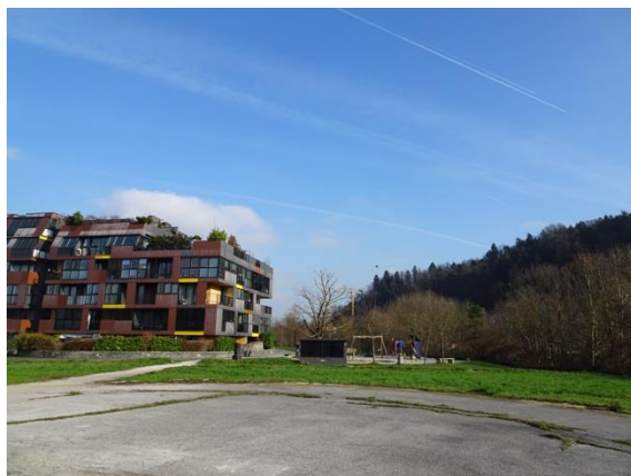
14: Pogled na otroško igrišče
