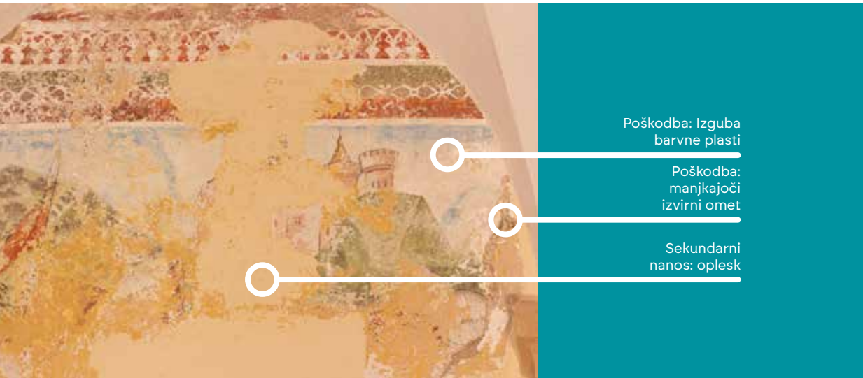
Slika 7: Primer različnih poškodb in prekritij na stenski sliki. Osebni arhiv in foto: B. Šeme.
