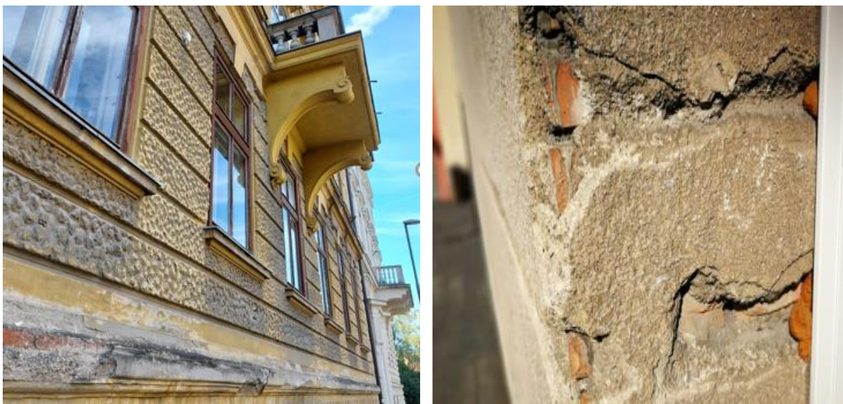
Slika 19: Zunanje stene stavb
