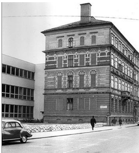
Slika 4: Starejši del stavbe
