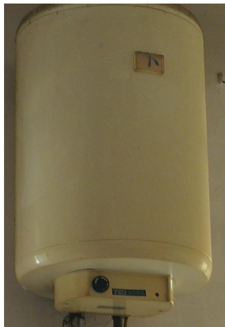
Slika 12: Lokalni grelnik tople sanitarne vode
