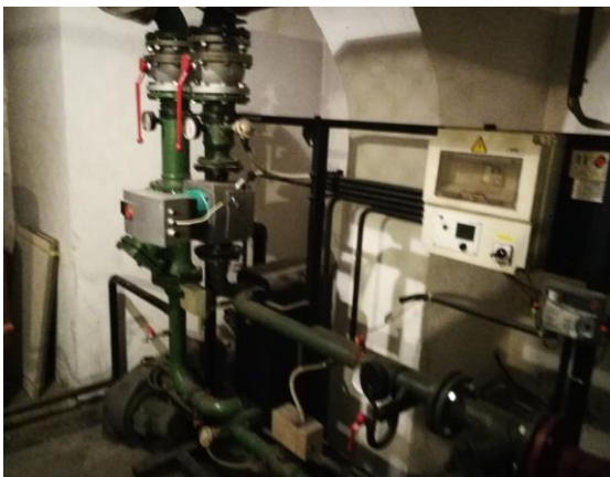
Slika 9: Toplotna podpostaja
