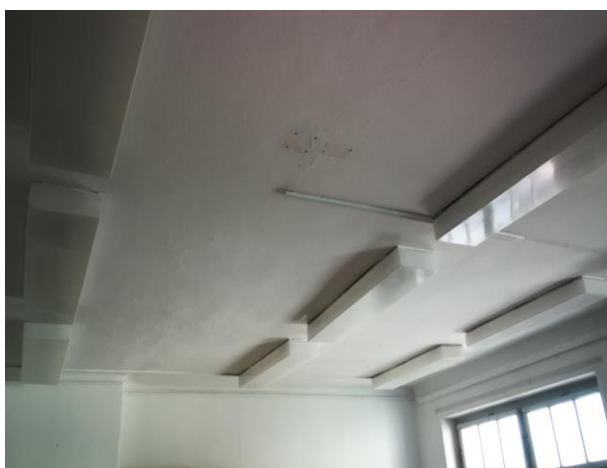
Slika 12: Svetilke s fluorescentnimi sijalkami
