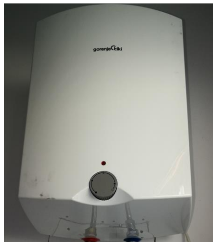
Slika 11: Lokalni grelnik tople sanitarne vode
