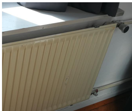
Slika 9: Panelno grelno telo s klasičnim ventilom
